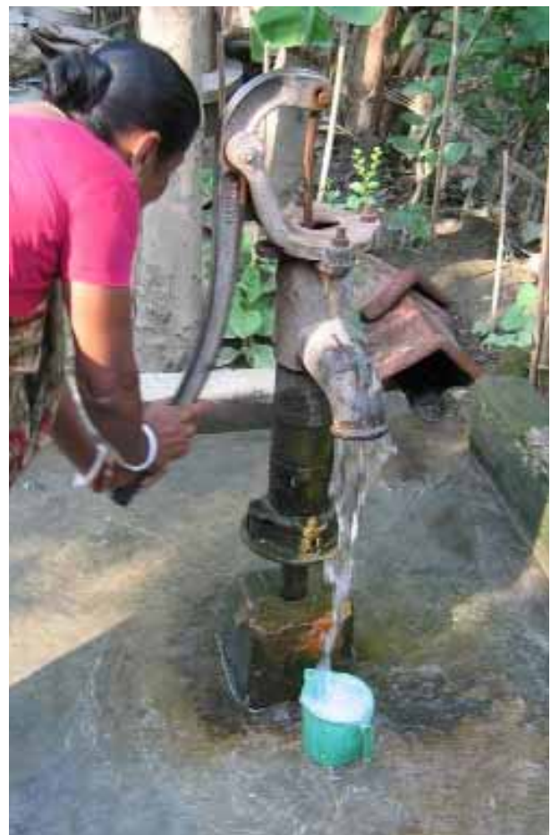
ARRIBA Y DERECHA - Mujeres de la comunidad de Vidyasagar de la colonia de Kalyani, en la Municipalidad de West Bengal, India, decidieron pavimentar las bases de todas las 69 bombas manuales de su colonia y construyeron plataformas de cemento para evitar la acumulación de aguas sucias, basura y mugre alrededor de sus fuentes de agua segura. La Municipalidad les proporcionó una cantidad de ladrillo no utilizado y el resto lo hicieron ellas por si solas. Todo sucedió al cabo de dos meses de haber recibido su calificación LDCA. Este fue el primer tugurio en lograr la calificación LDCA. Después de un año, los 52 tugurios dentro de la municipalidad fueron declarados LDCA.
