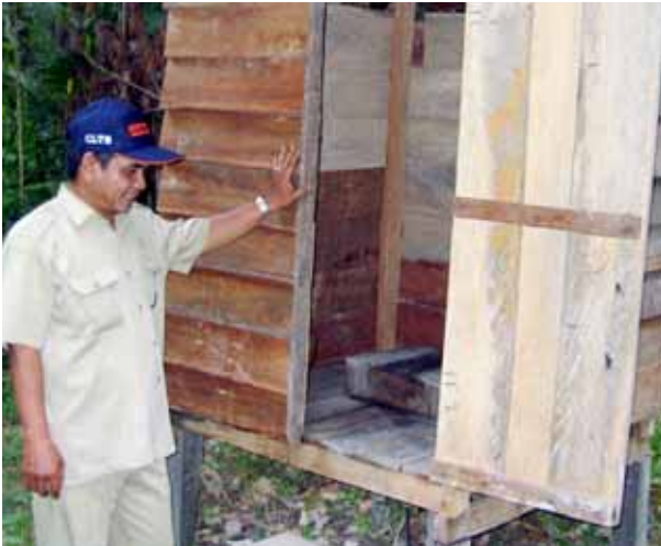
ARRIBA Plataforma elevada de un inodoro para evitar las inundaciones estacionales en Indonesia.
