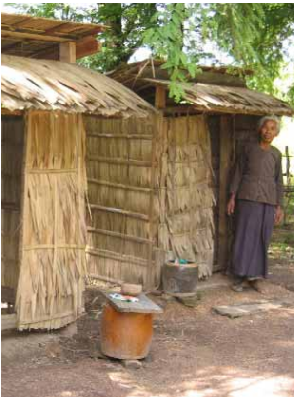
ARRIBA Note el recipiente de agua y jabón delante de algunas letrinas recién construidas en las aldeas de la provincia de Kampung Spu en Camboya
