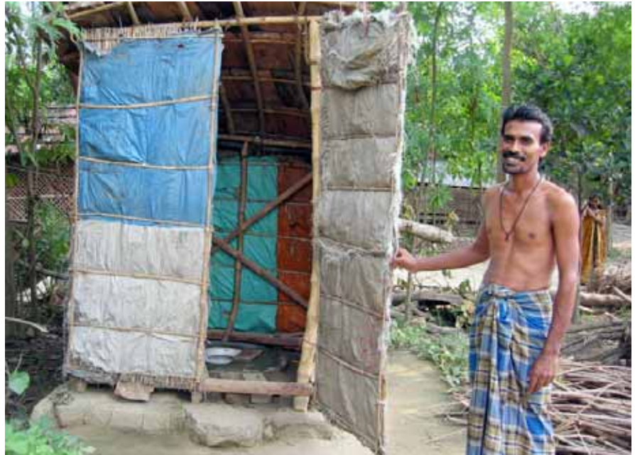
BA El uso de bambú y plásticos para la estructura, mientras la base es fuerte y perfecta. Colonia Vidyasagar, Kalyani, Bengal Occidental, India.
