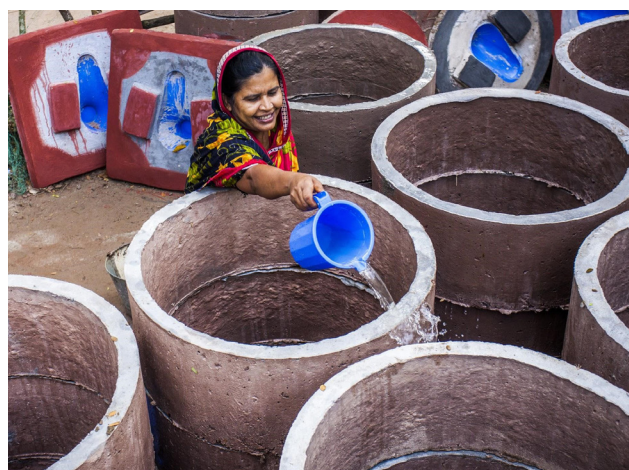
Les anneaux sont importants pour tapisser la fosse. Crédit photo : iDE
