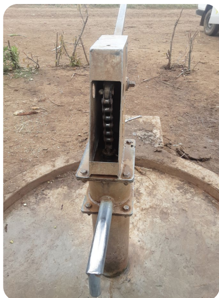
Figure 3. Pompe dans le Karamoja sans couvercle d'inspection ni vis (G) et pompe vandalisée dont le levier a été utilisé pour le labourage (D).
