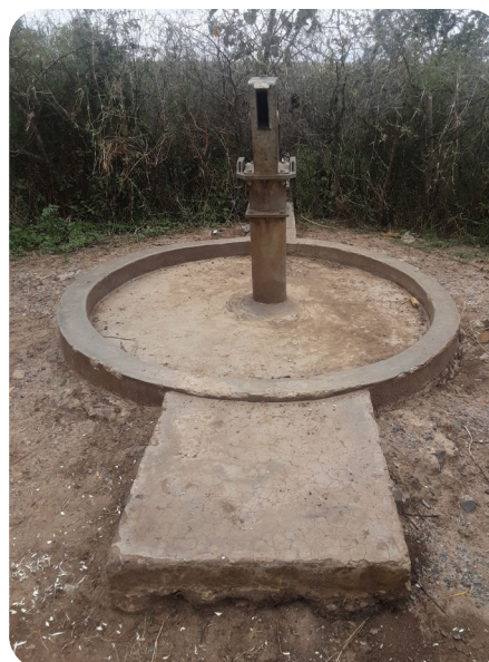
Figure 3. Pompe dans le Karamoja sans couvercle d'inspection ni vis (G) et pompe vandalisée dont le levier a été utilisé pour le labourage (D).
